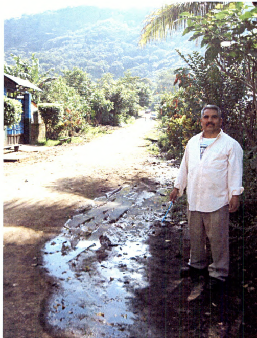
Fotografía que muestra la inundación en calle principal, por la escorrentía superficial.
